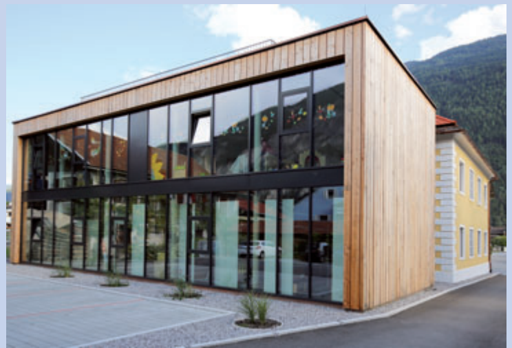
Sanierung und Zubau »Klösterle« in Silz
